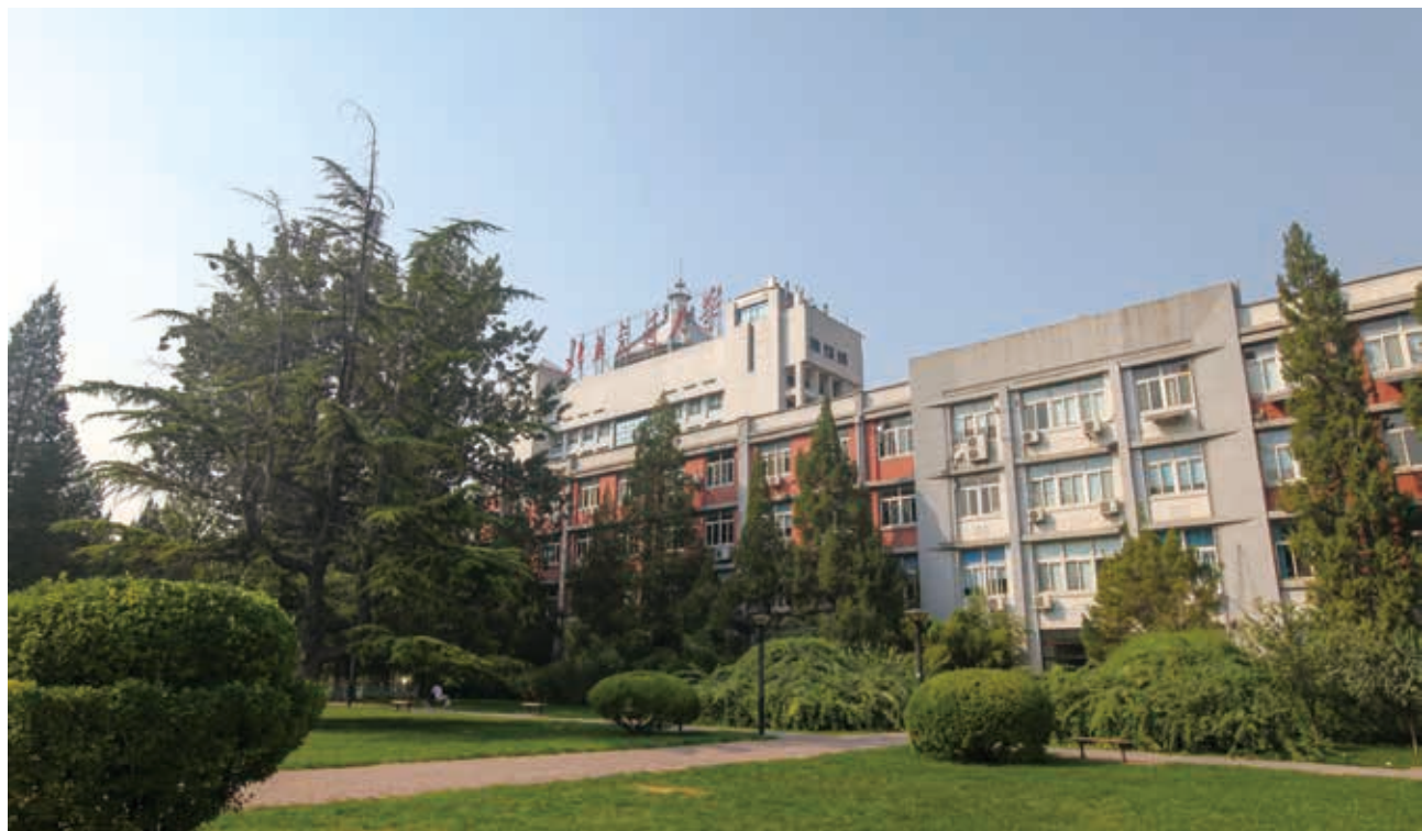
北京交通大学老旧楼改造项目使用了北新防水“墙丽衣”装饰一体化系统
