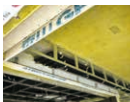
承重部位加固基层
