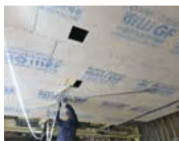
全空间吊顶基层
