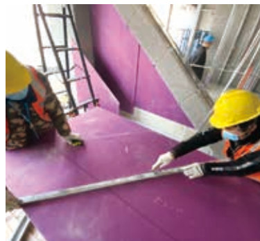
项目施工现场
