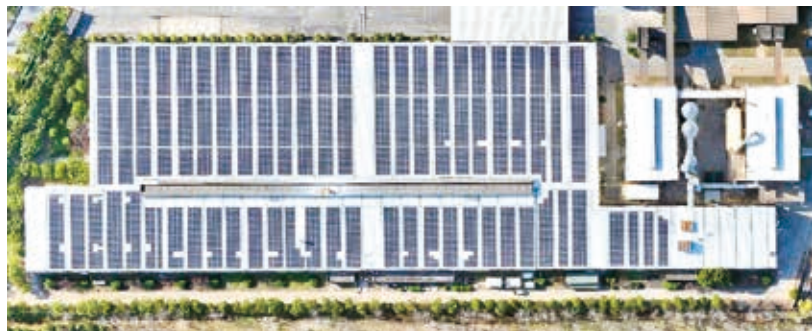
苏州北新联合车间屋面BIPV分布式光伏发电项目
