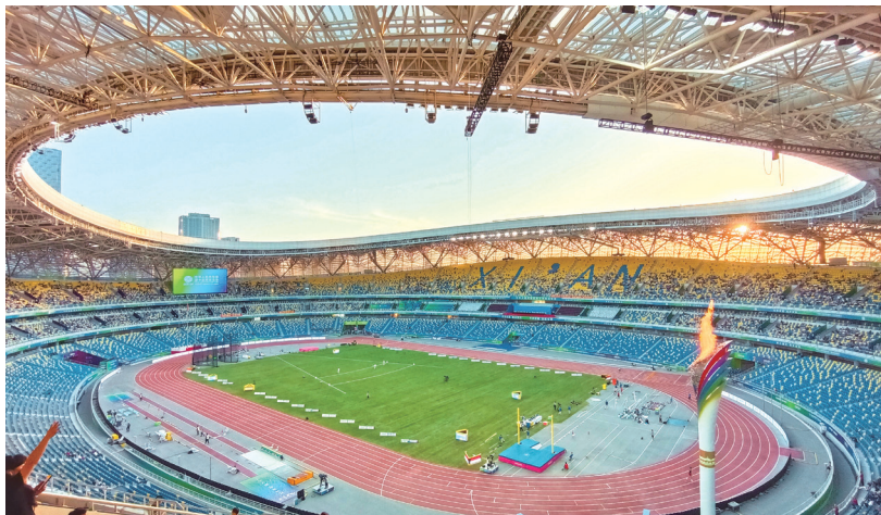
西安奥体中心主体育场内场
